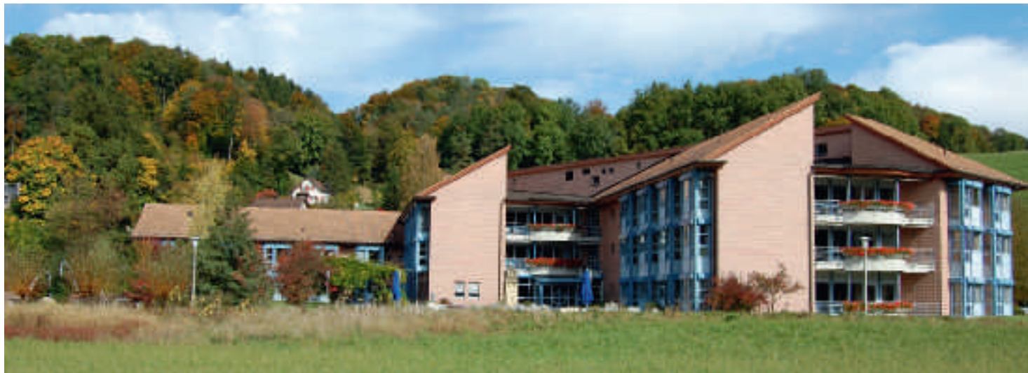
Der Zweckverband Altersheime Tösstal geht neue Wege
